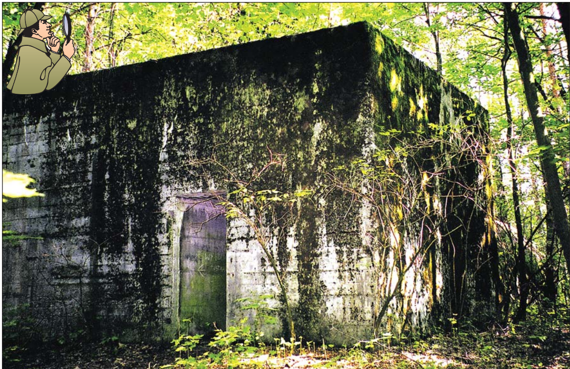
Wejście do ponemieckiego schronu przeciwlotniczego, których sporo zbudowano w Blechhammer i jej okolicach.
